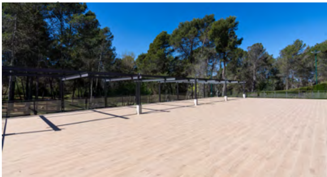
Zona de la piscina renovada
